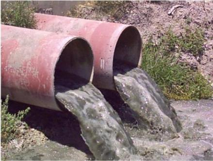
La cantidad de OD es la variable fundamental a medir para determinar el grado de contaminación por materia orgánica biodegradable de un río pues bajas concentraciones de oxígeno producen desajustes en el ecosistema, mortalidad de peces, olores y otros efectos desfavorables.
